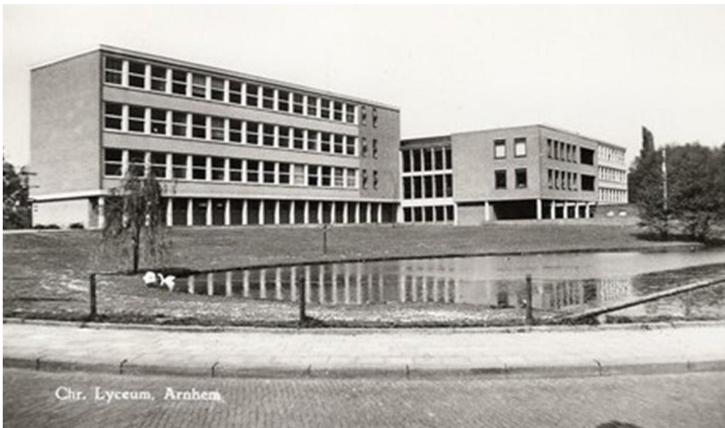
Fig. 8 - Het nieuwe Christelijk Lyceum Arnhem (CLA) in 1964. Enkele jaren later wordt het hoge deel van de beekdalvloer afgedekt met een laag zand voor de bouw van het CLA (geopend in 1964). Het lage venige deel wordt uitgegraven voor de aanleg van de vijver en de oprijlaan van de school.
